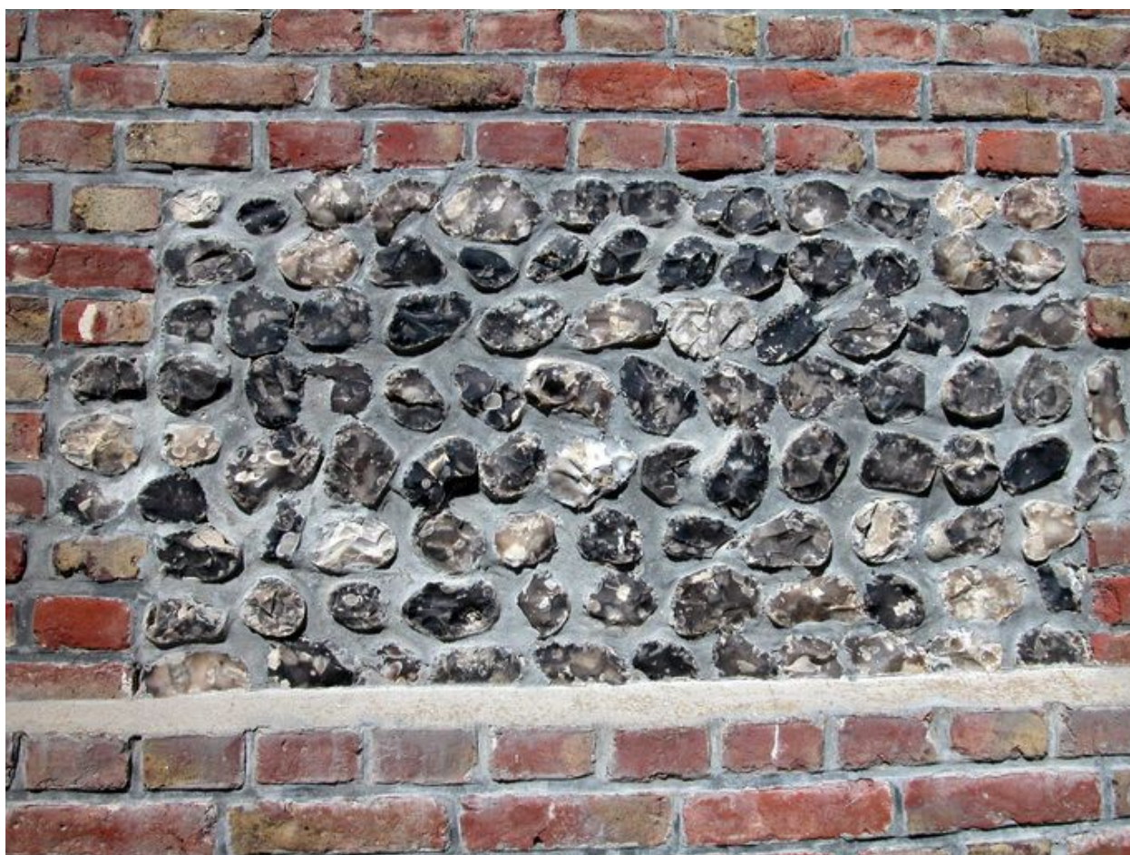
Détail du gros-oeuvre apparent.
