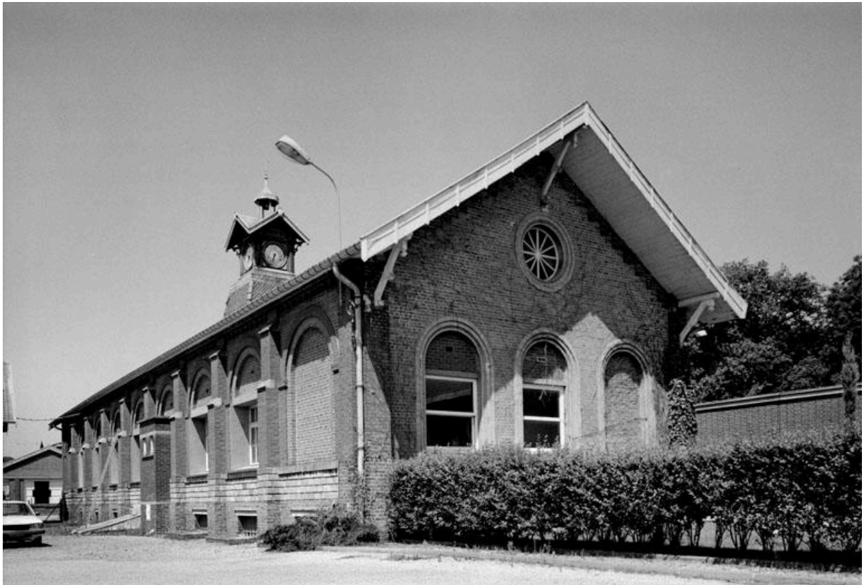
Réfectoire d'entreprise portant la date de 1891 au sommet du clocheton.
