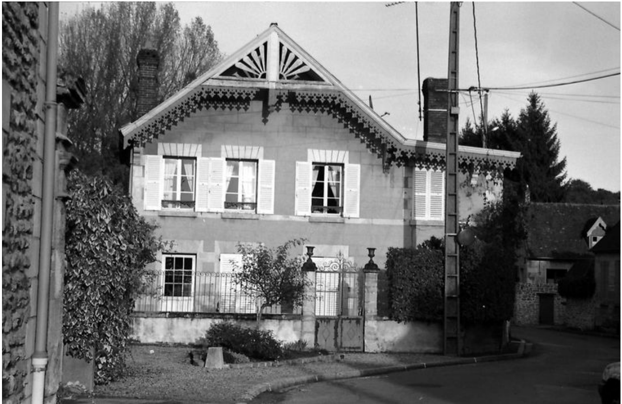
Maison patronale, façade sur rue.
