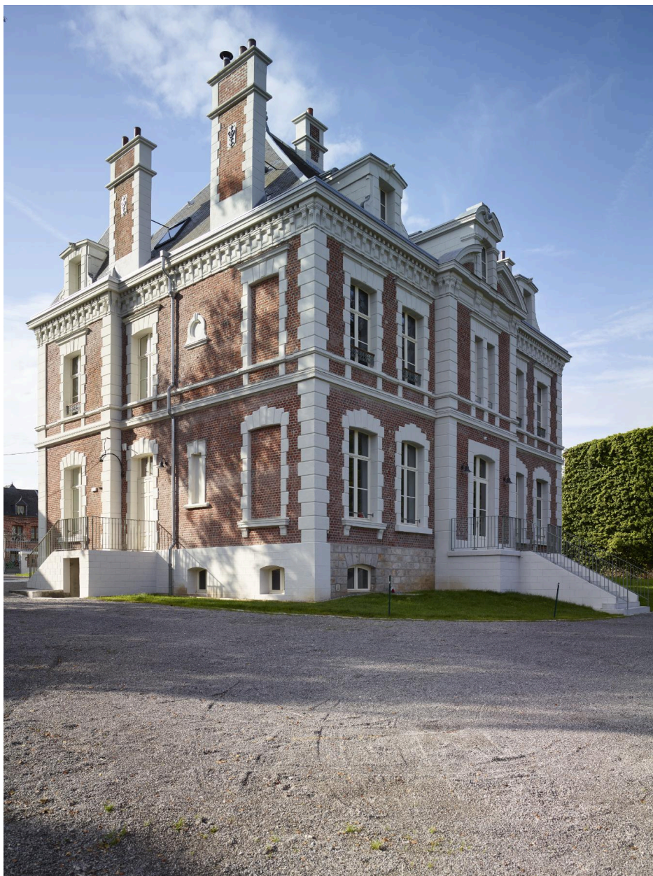
Ancienne gendarmerie : façade latérale droite et façade arrière.
