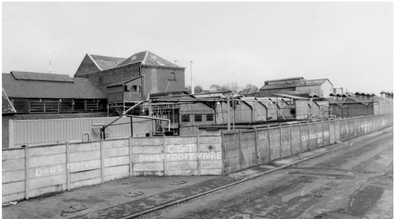
Les anciens ateliers de teinture, vus depuis le sud-ouest.
