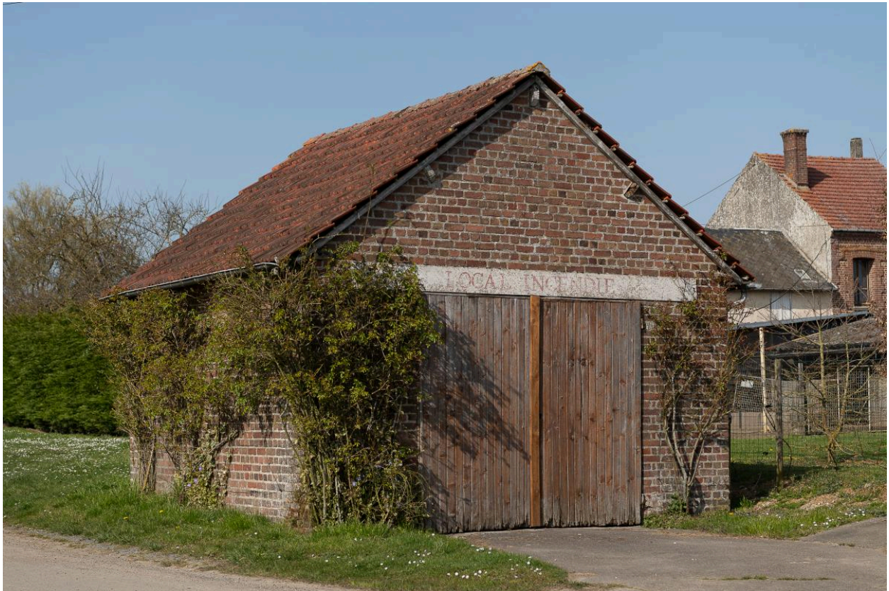
Remise des pompes à incendie, Neuve Rue, vue depuis le sud-est.
