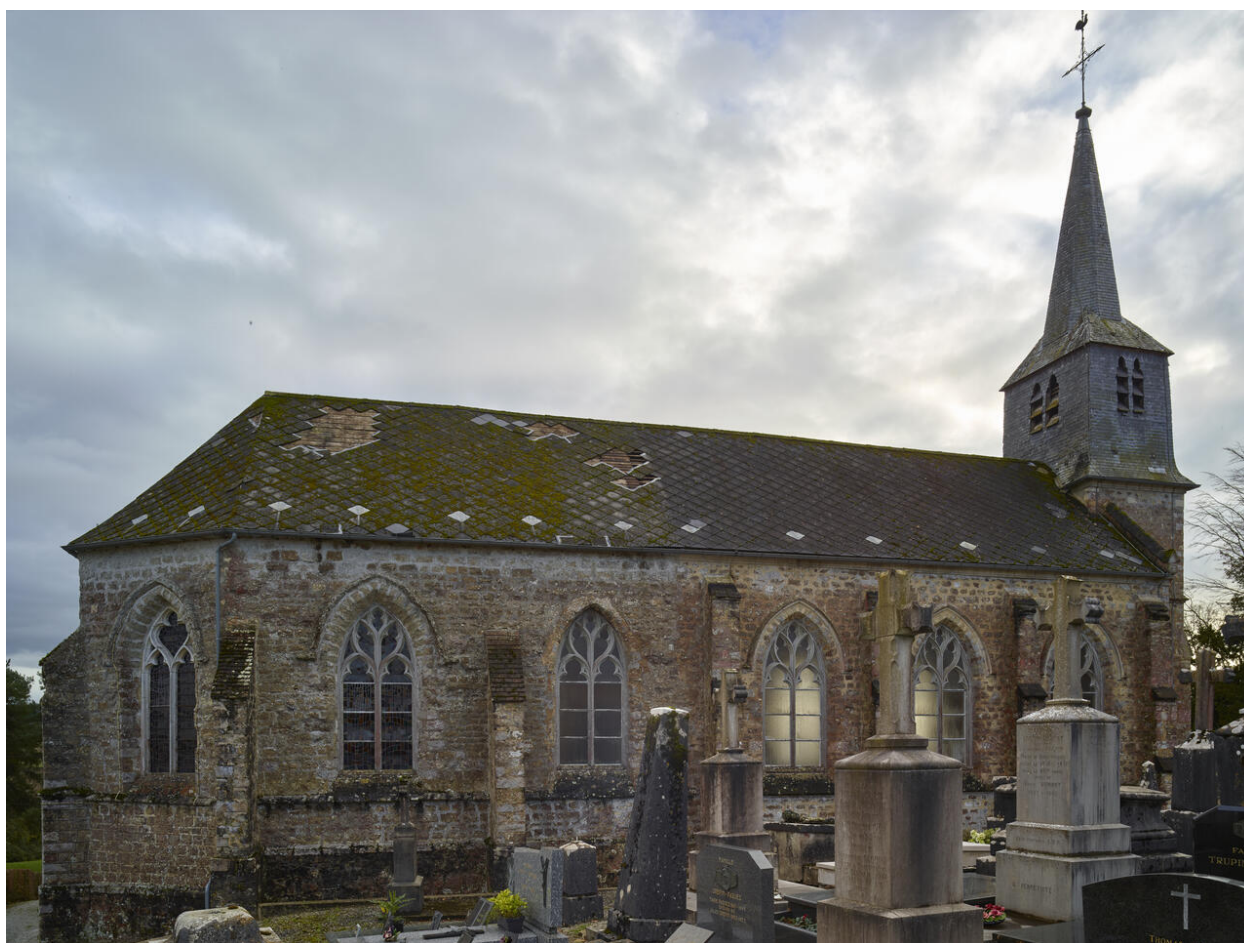
Vue de l'élévation nord.
