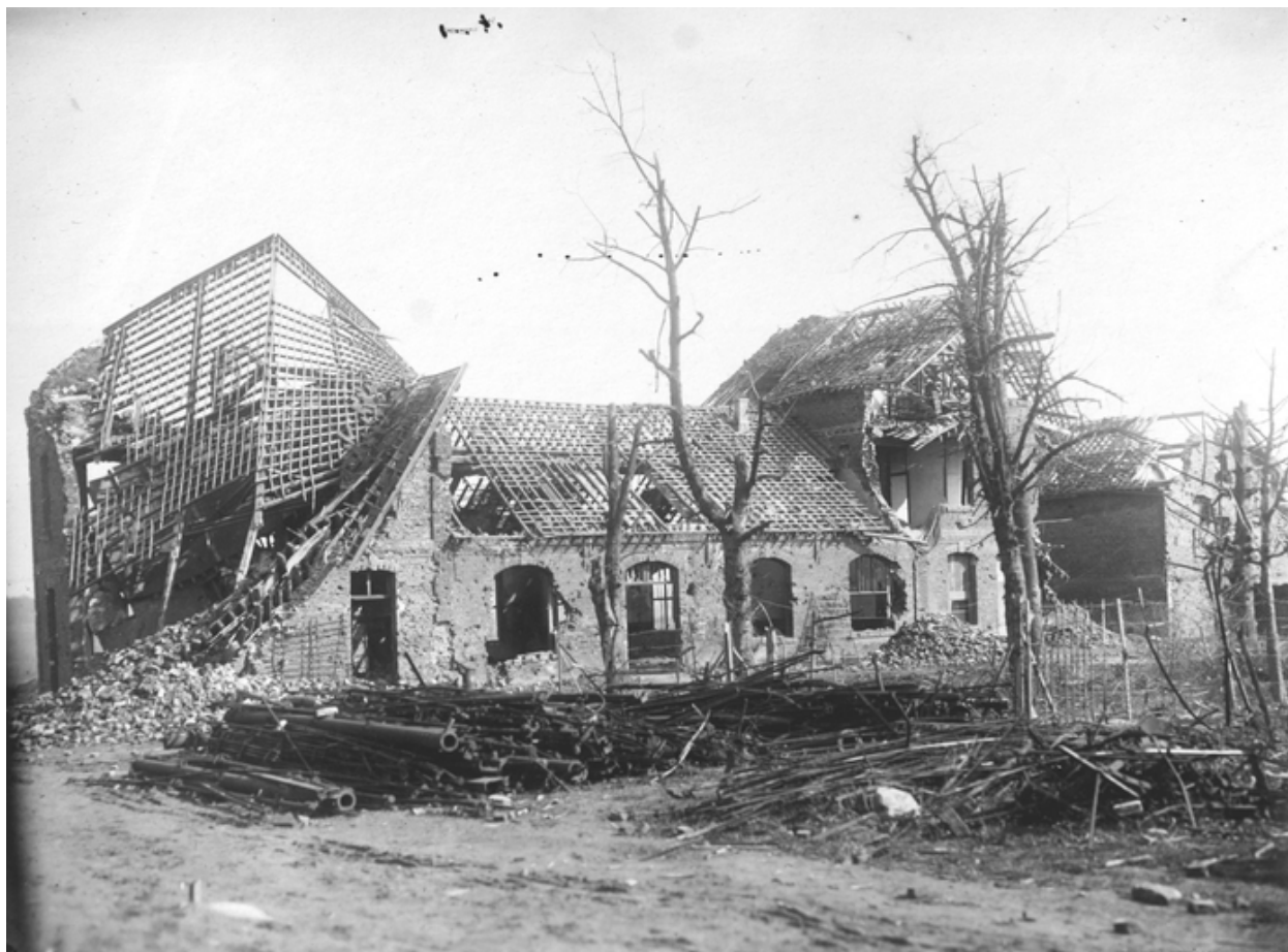
Façade postérieure de la cantine, vers 1919 (AD Aisne).
