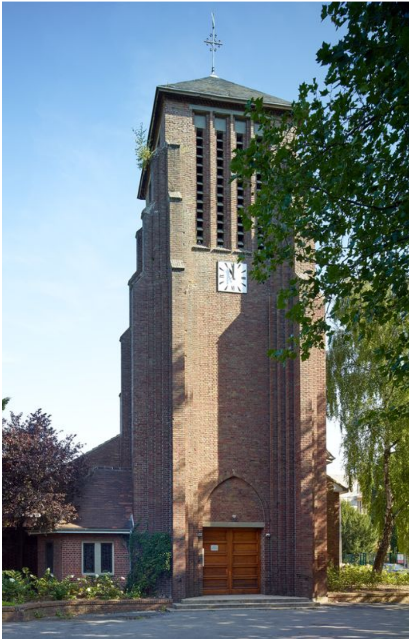
Élévation principale côté sud.
