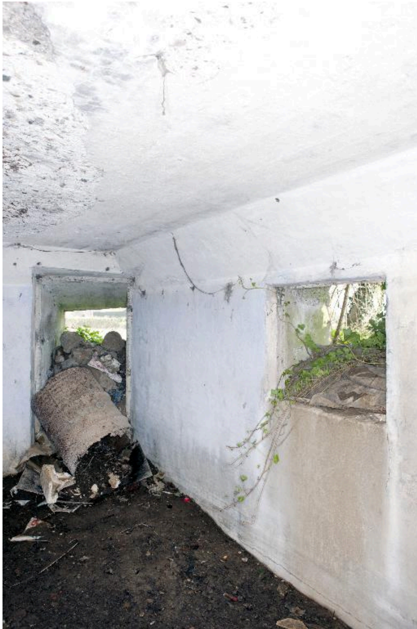
Intérieur de l'édifice depuis l'entrée sud
