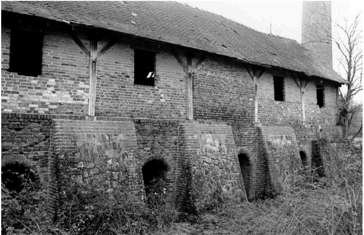
Atelier de fabrication : vue des entrées du four Hoffmann (Ecomusée du Beauvaisis).
