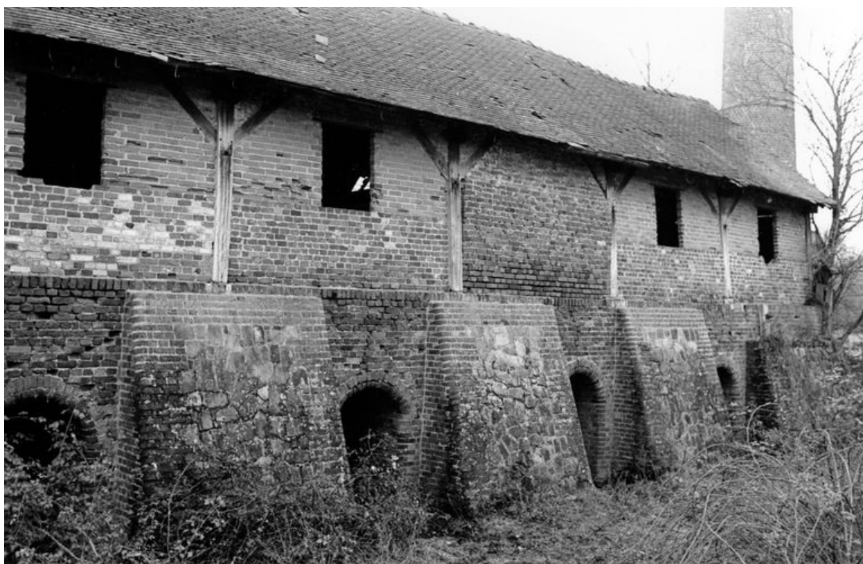
Atelier de fabrication : vue des entrées du four Hoffmann (Ecomusée du Beauvaisis).
