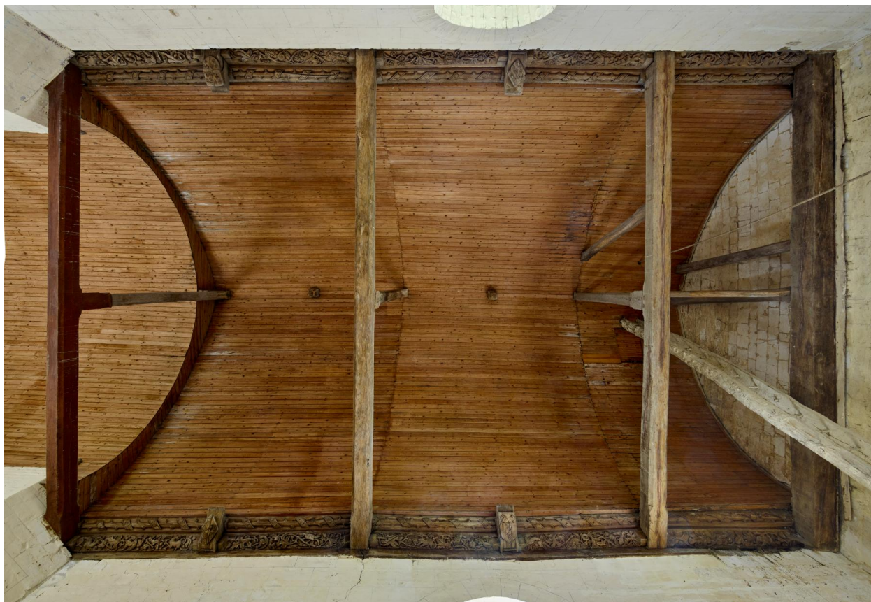
Intérieur, ensemble de la voûte de la nef et des sablières sculptées.
