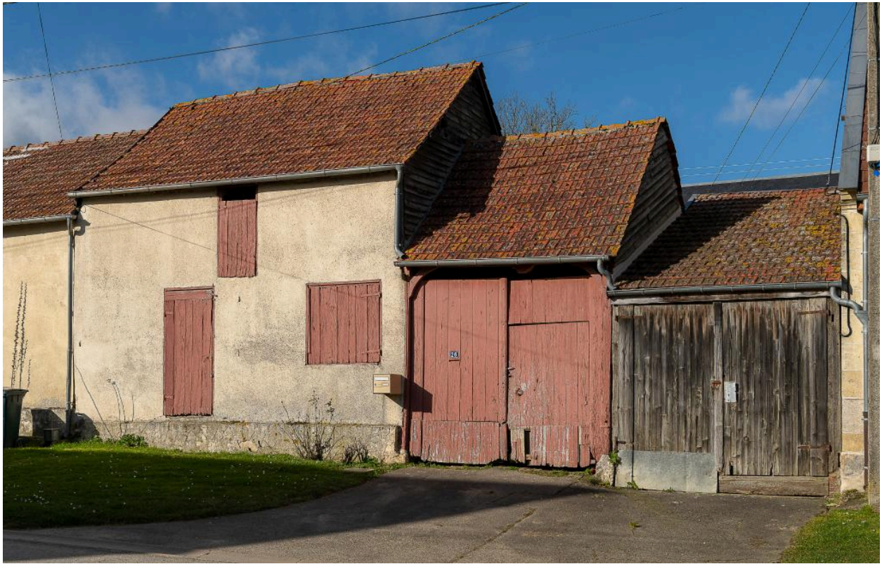
Bâtiment de grange et d'atelier de serger (?) prolongé d'une entrée charretière, n°26 Grande Rue, vue depuis le sud.
