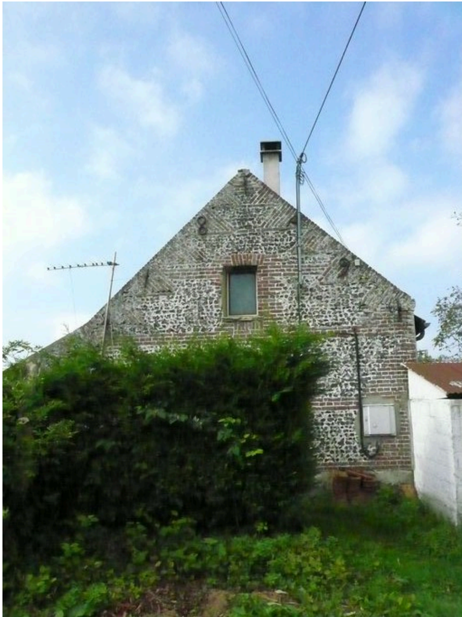
Vue du pignon sur rue, daté de 1849.
