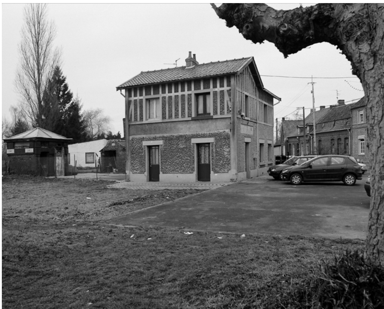
Vue générale, depuis la rue Jacques-Varlet.
