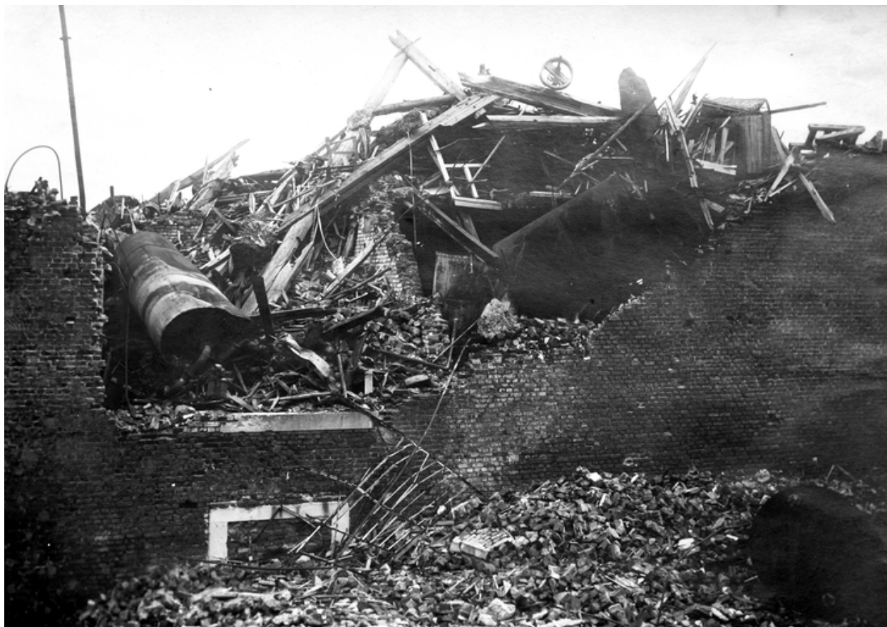
Les ruines de l'usine photographiées en 1919 (AD Aisne).
