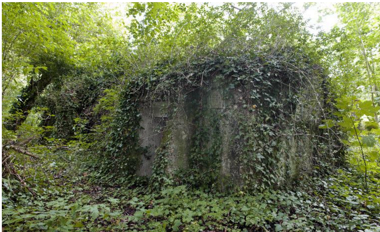
Casemate c) : Vue générale
