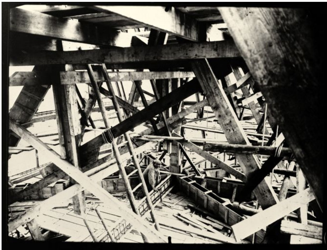
Construction de la charpente du choeur (photographie des années trente).
