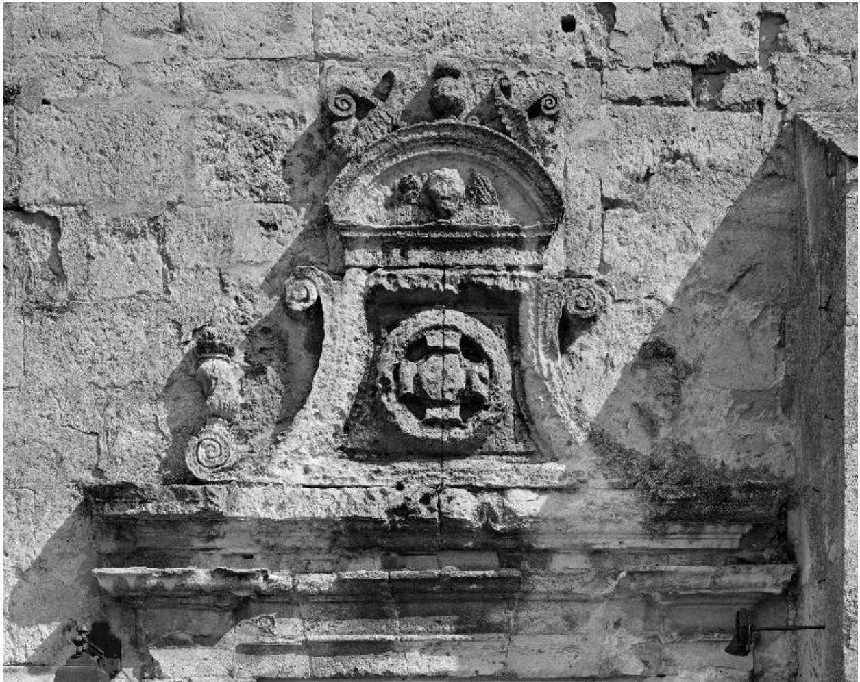
Élévation sur cour du corps de logis nord-est : détail du décor de la porte.
