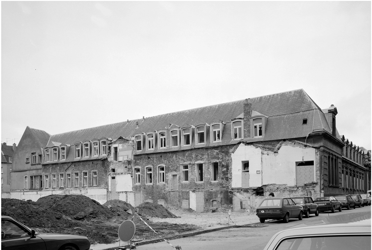
Bâtiment D, vue d'angle de la rue Saint-Louis.
