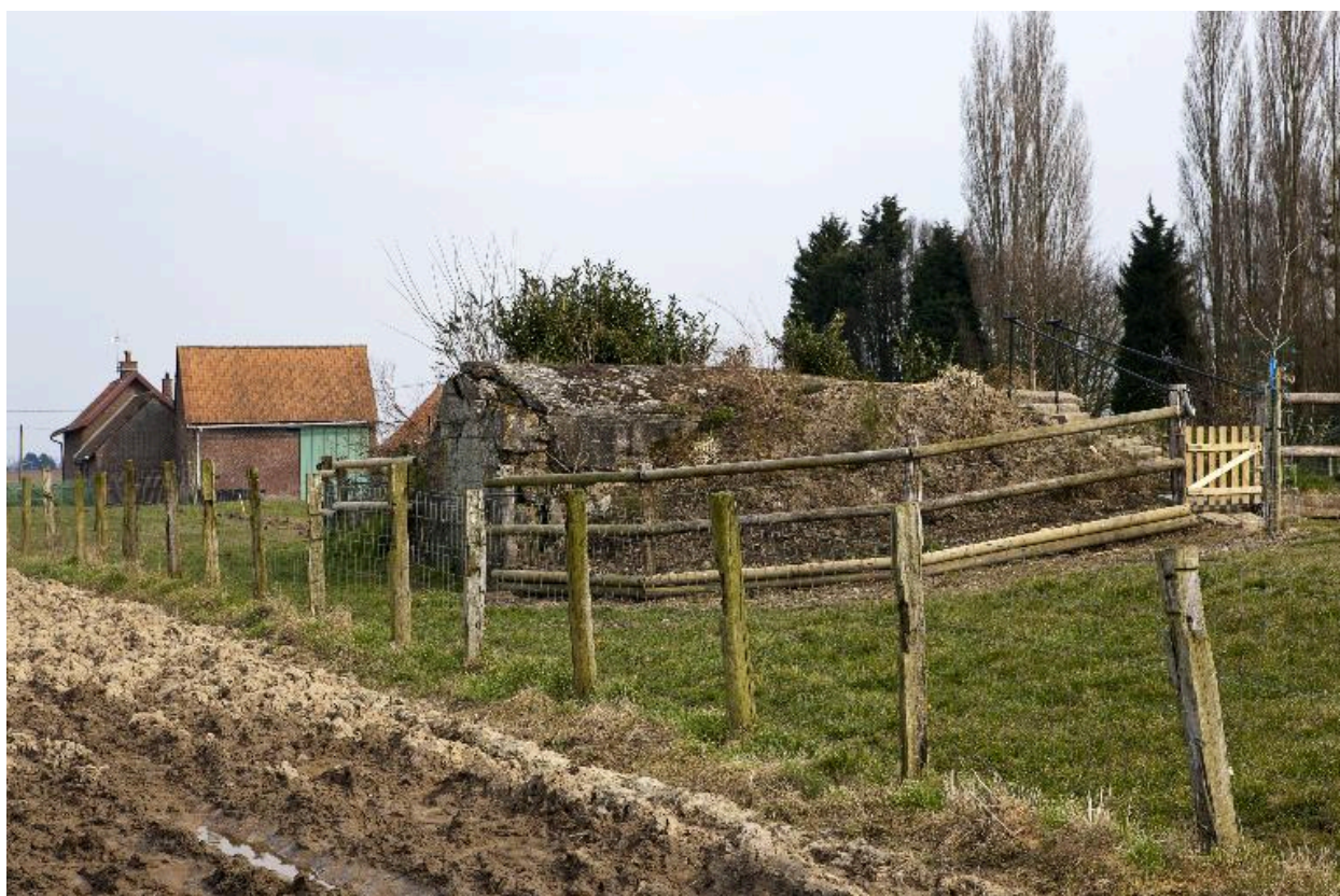
Vue de 3/ vers le sud-est
