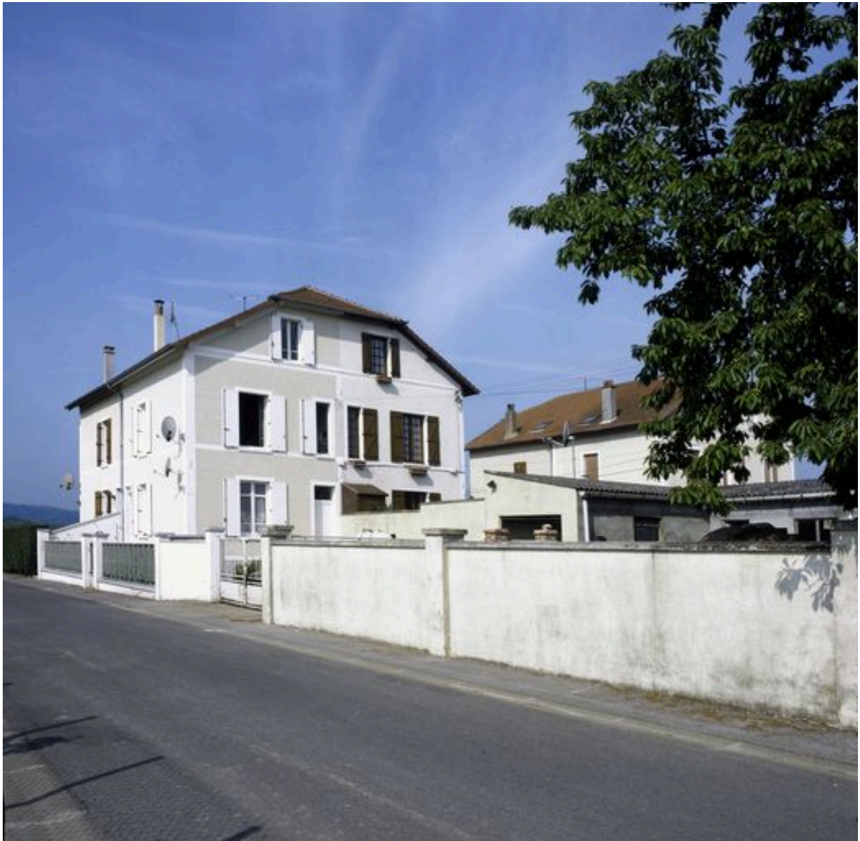
Vue des maisons situées à l'arrière.
