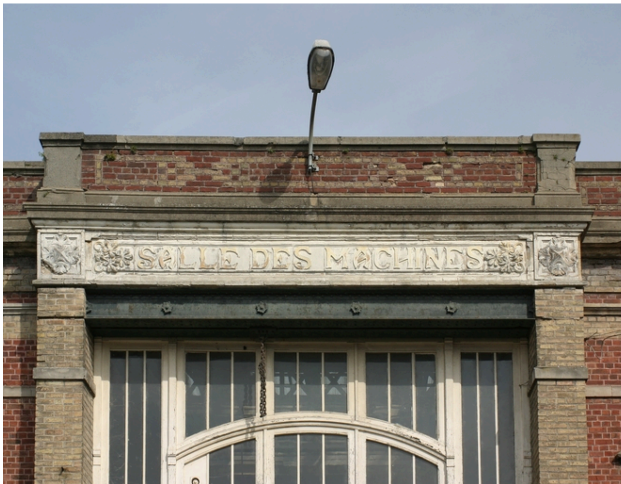
Salle de machines de 1913, détail.
