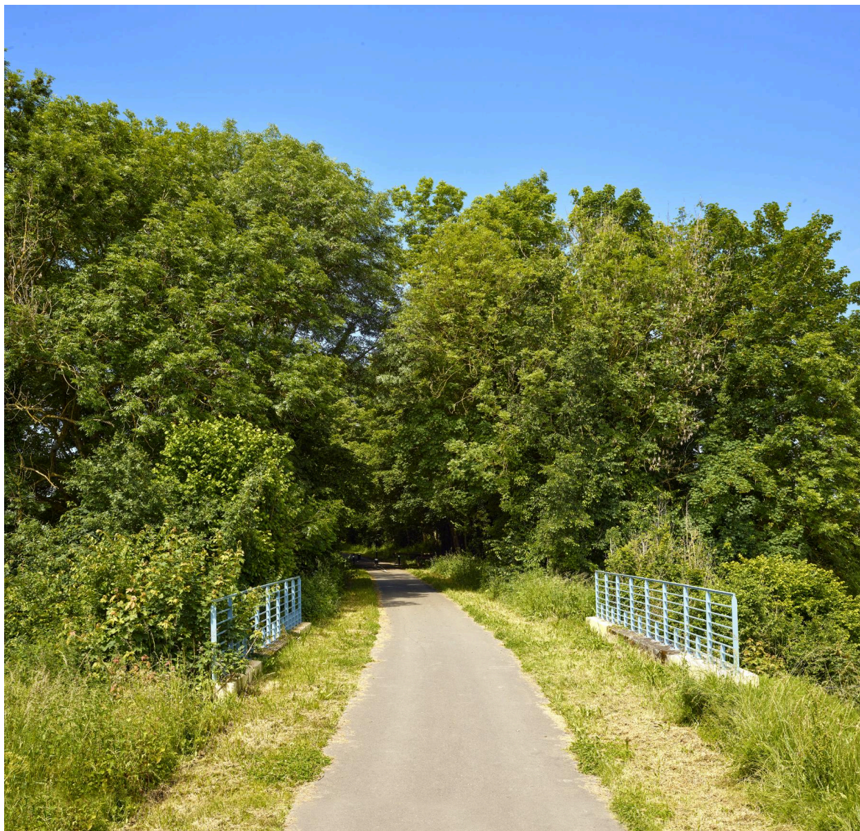
Traverse du Ponthieu, ancienne voie ferroviaire, au dessus de la rue du Haut.
