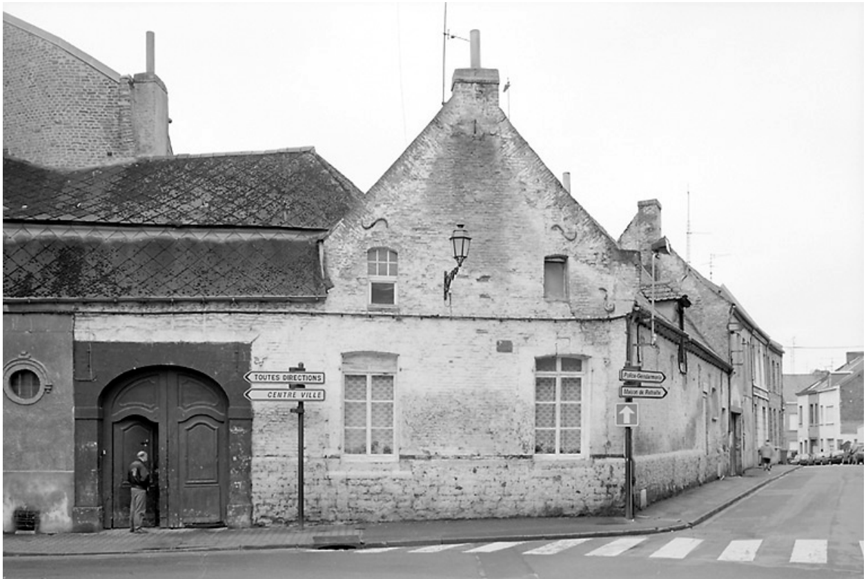
Vue partielle : corps de bâtiment faisant l'angle de la place Verte et de la rue de la Cavalerie (état en 2000).
