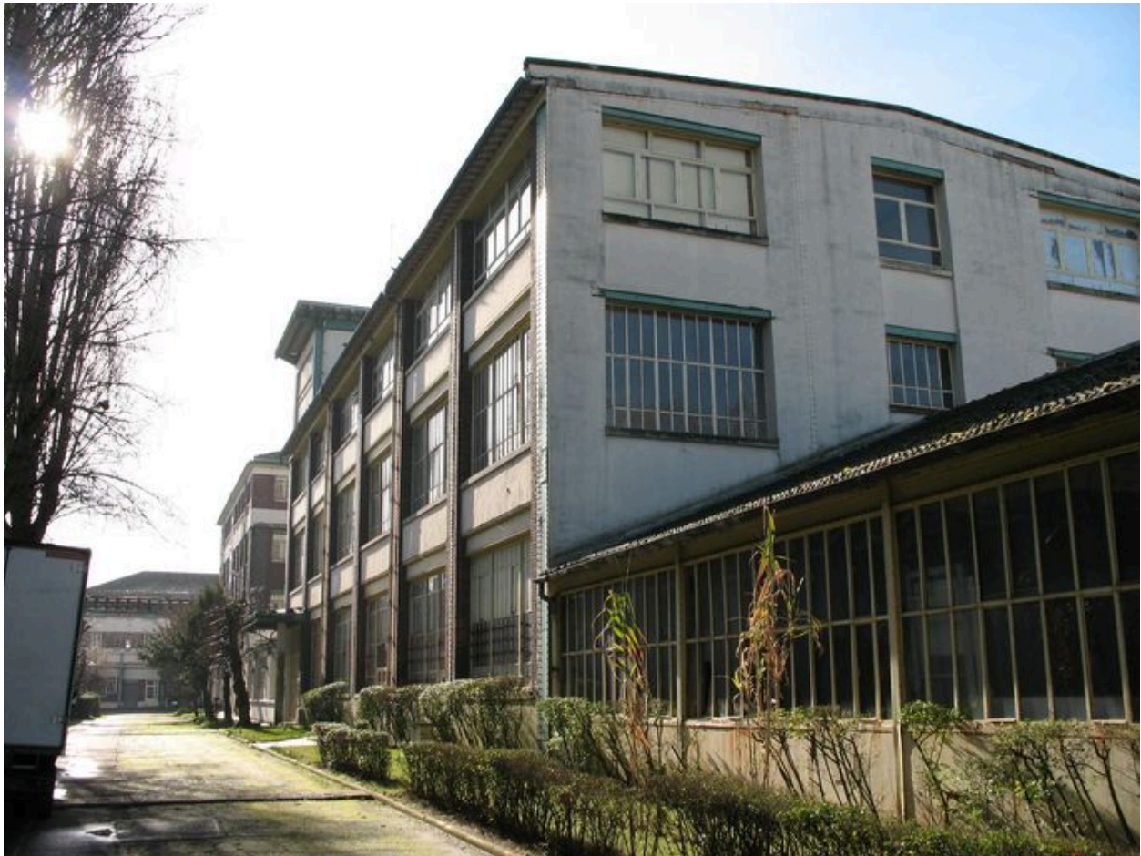
Les bâtiments de l'usine électrique transformés côté cour.
