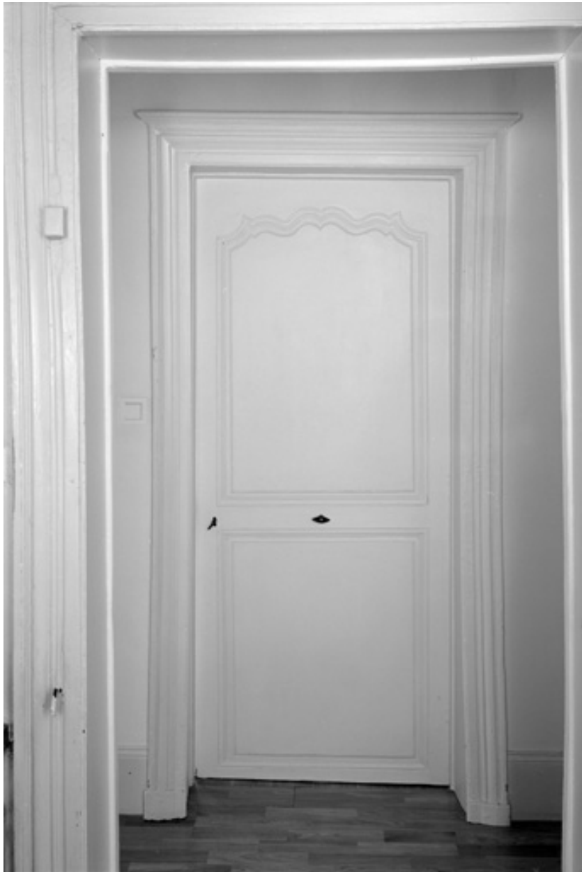
Porte d'une chambre au premier étage.
