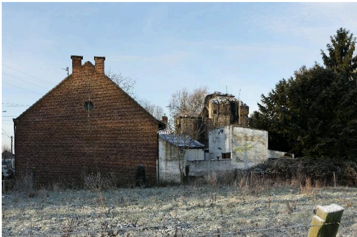
vue générale vers vers le sud
