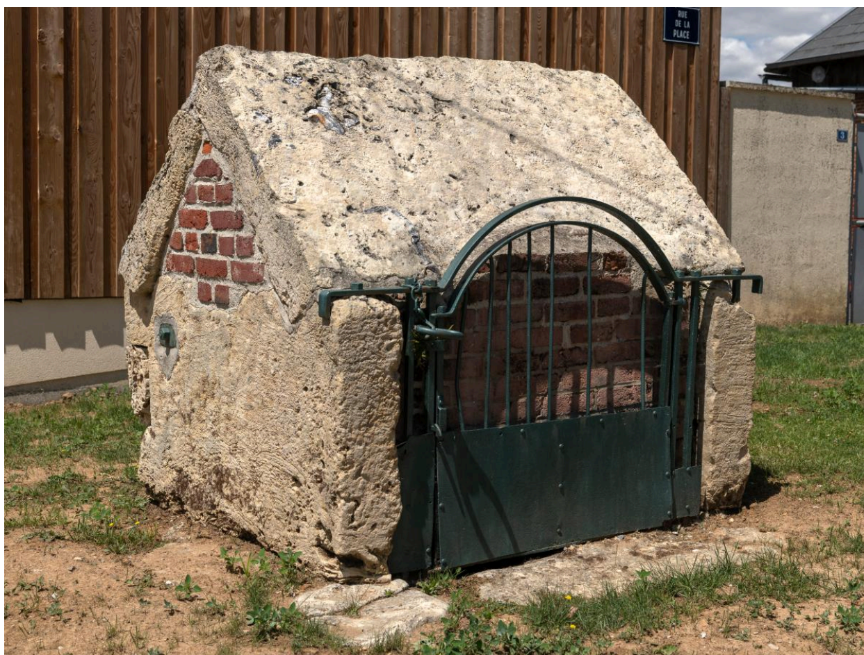
Puits en face du bâtiment des pompes, vue depuis le sud-est.
