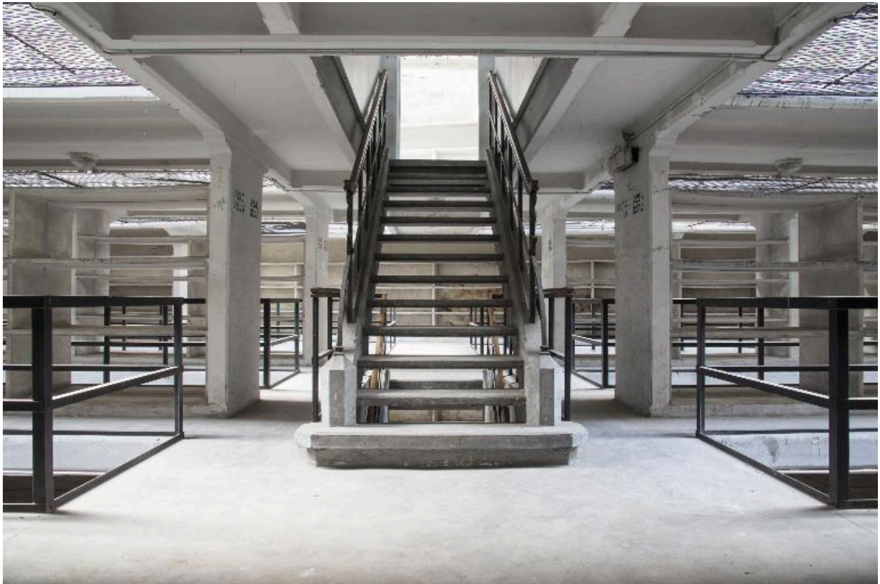
Bâtiment du dépôt, premier étage : vue de l'escalier depuis le vaisseau 2.
