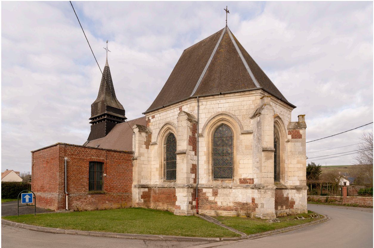
Vue générale depuis l'est.
