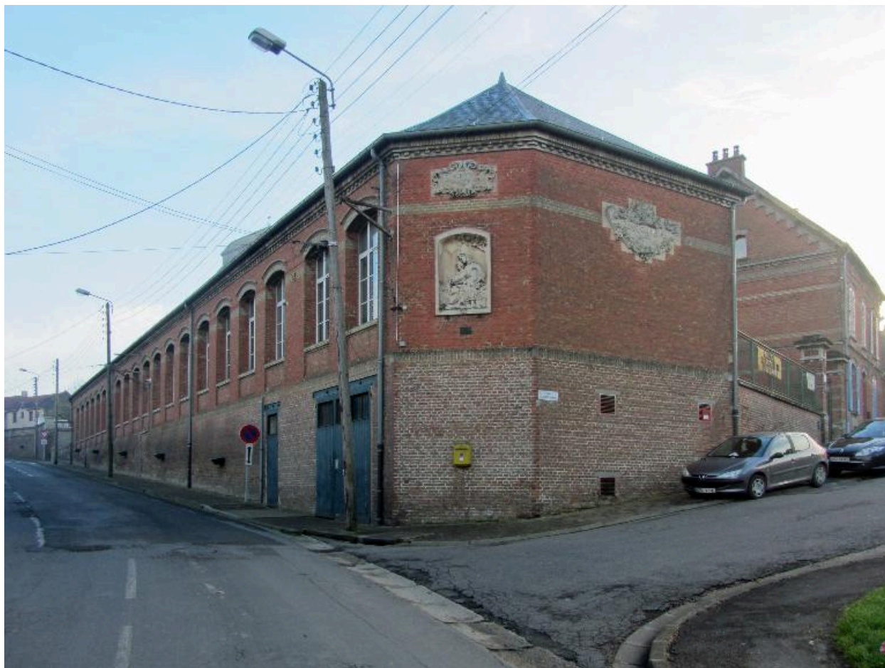
Vue d'ensemble sur rue.
