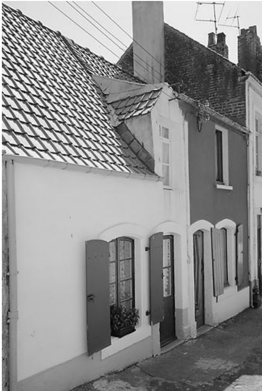
Vue d'ensemble sur voie.
