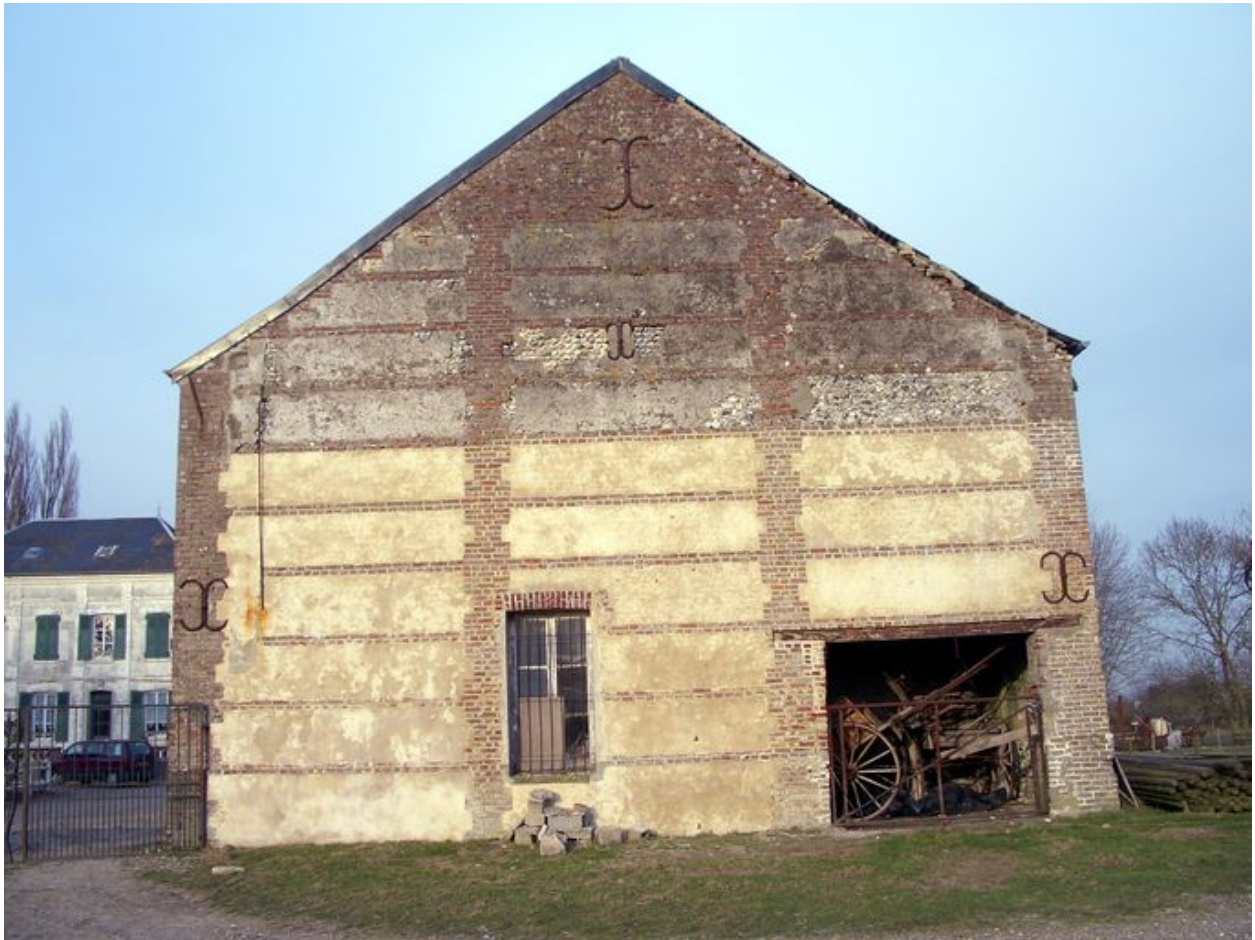
Vue du pignon des actuelles écuries.
