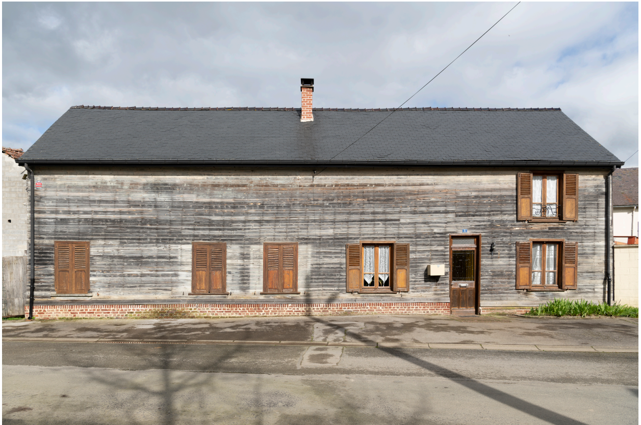
Logis sur rue avec essentage en bois, n°5 de la rue du Duc, vue prise depuis le sud.
