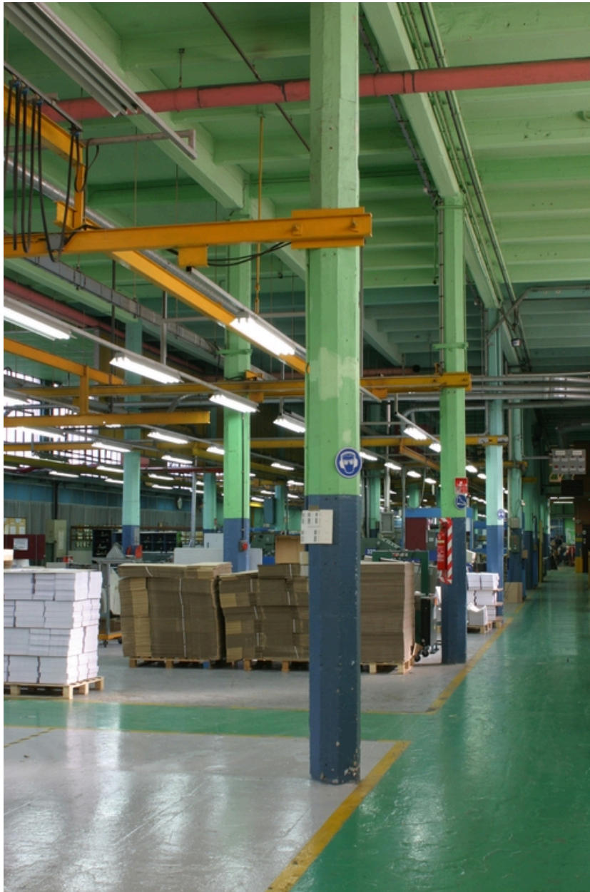
Vue intérieure des ateliers construits en 1919.
