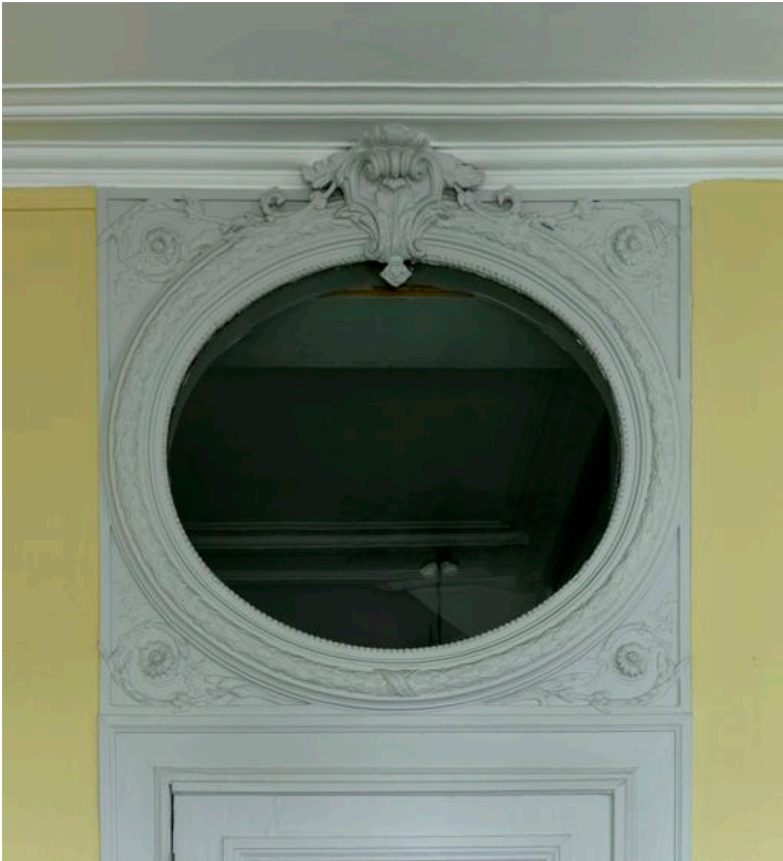
Imposte de l'antichambre (cabinet) du rez-de-chaussée.
