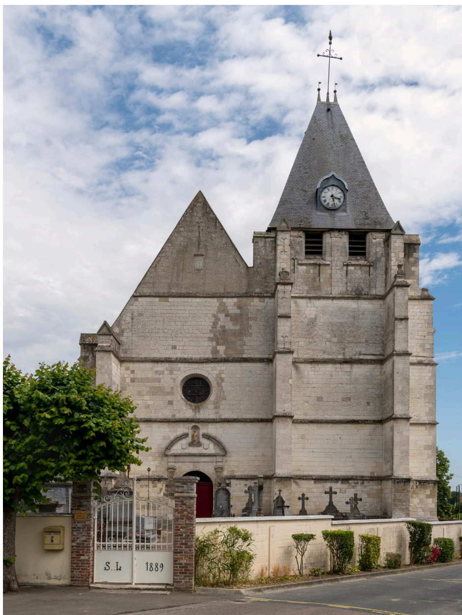
Vue générale de la façade occidentale avec le cimetière.
