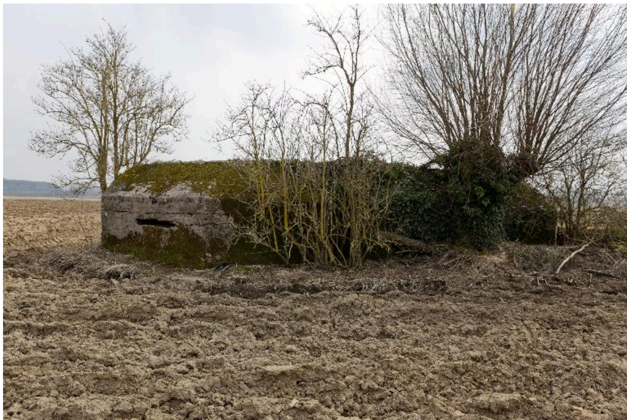
Vue vers le sud-est
