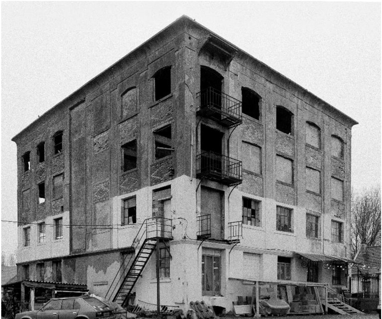
Vue d'ensemble sur cour de la minoterie en 1990.
