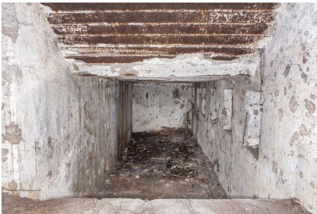
Vue générale, depuis le premier niveau de l'édifice vers le niveau intermédiaire
