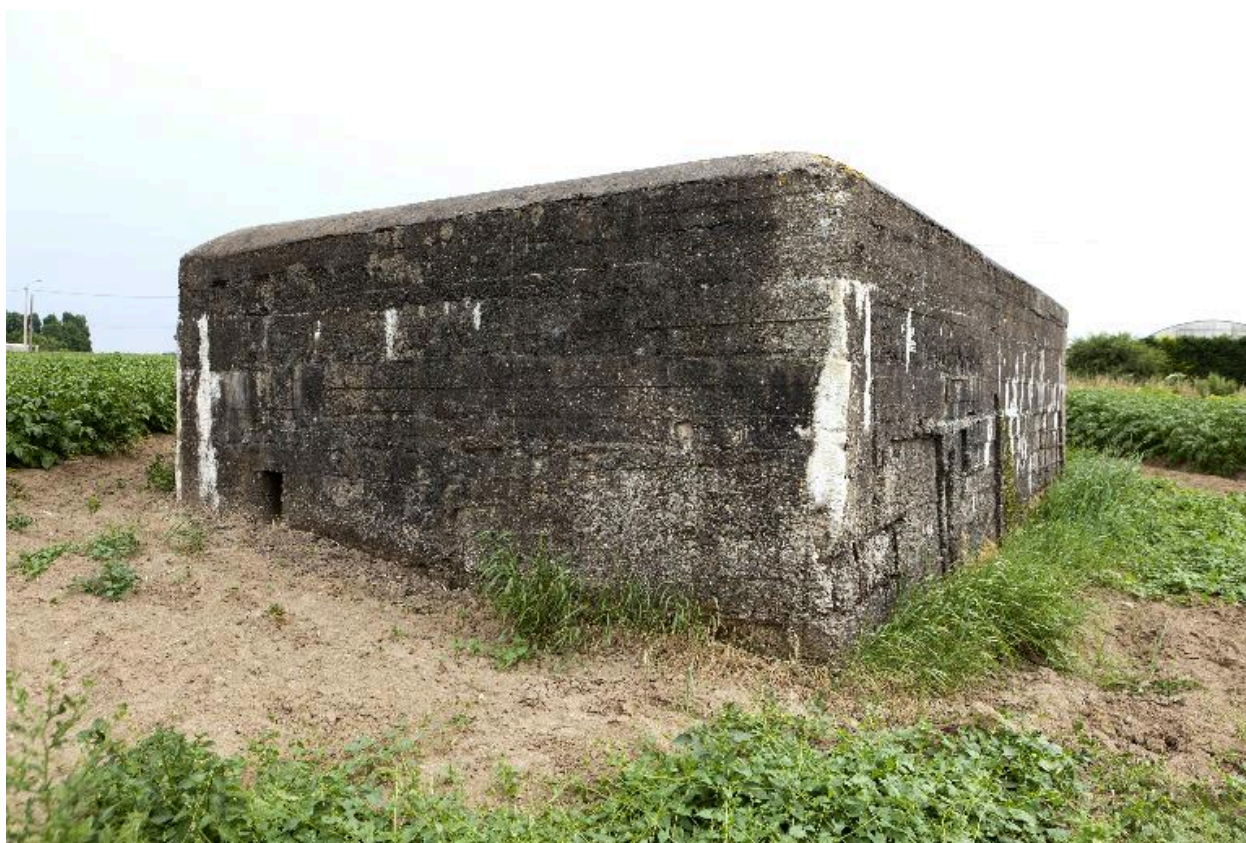
Vue de trois-quarts, vers le sud. En bas, à gauche, un créneau de fusillade
