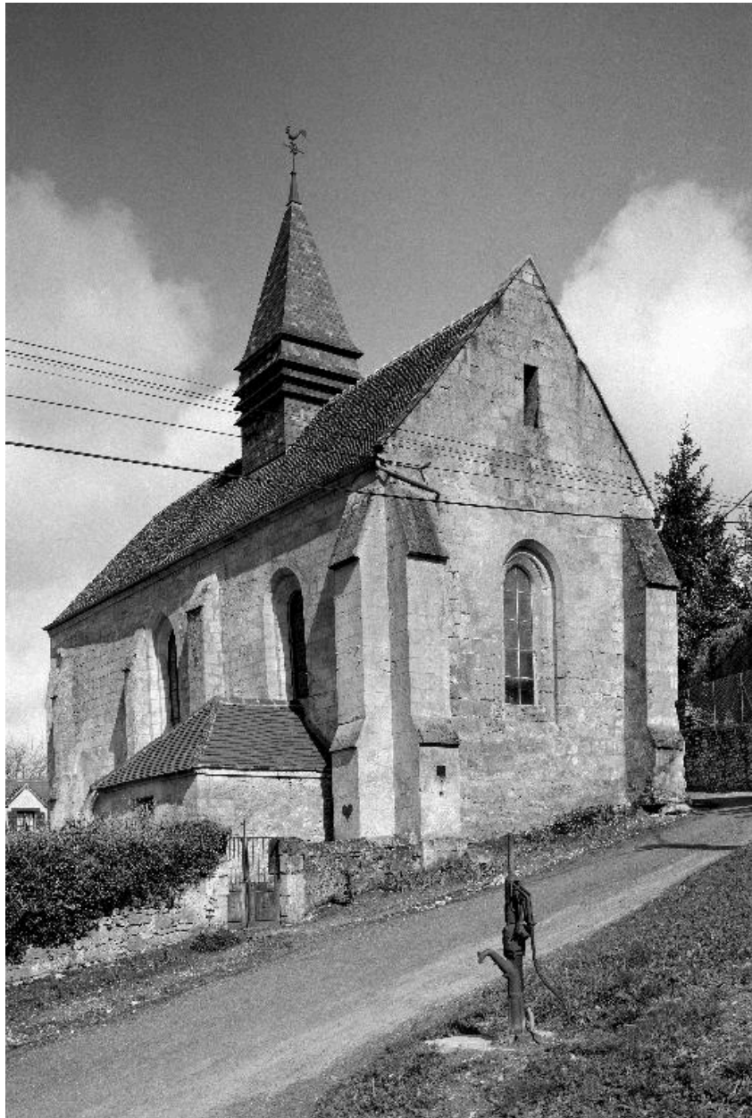
Vue générale de l'église, depuis le sud-est.
