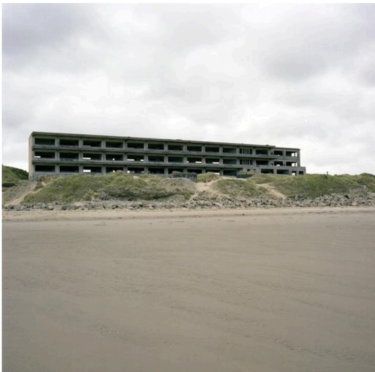
Elévation antérieure, vue générale prise de face.
