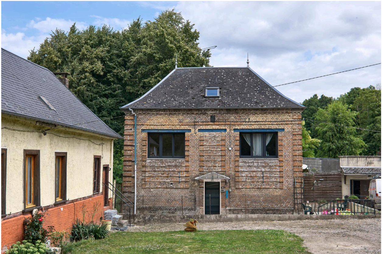
Ancienne école de Viulaines, vue prise depuis l'ouest.
