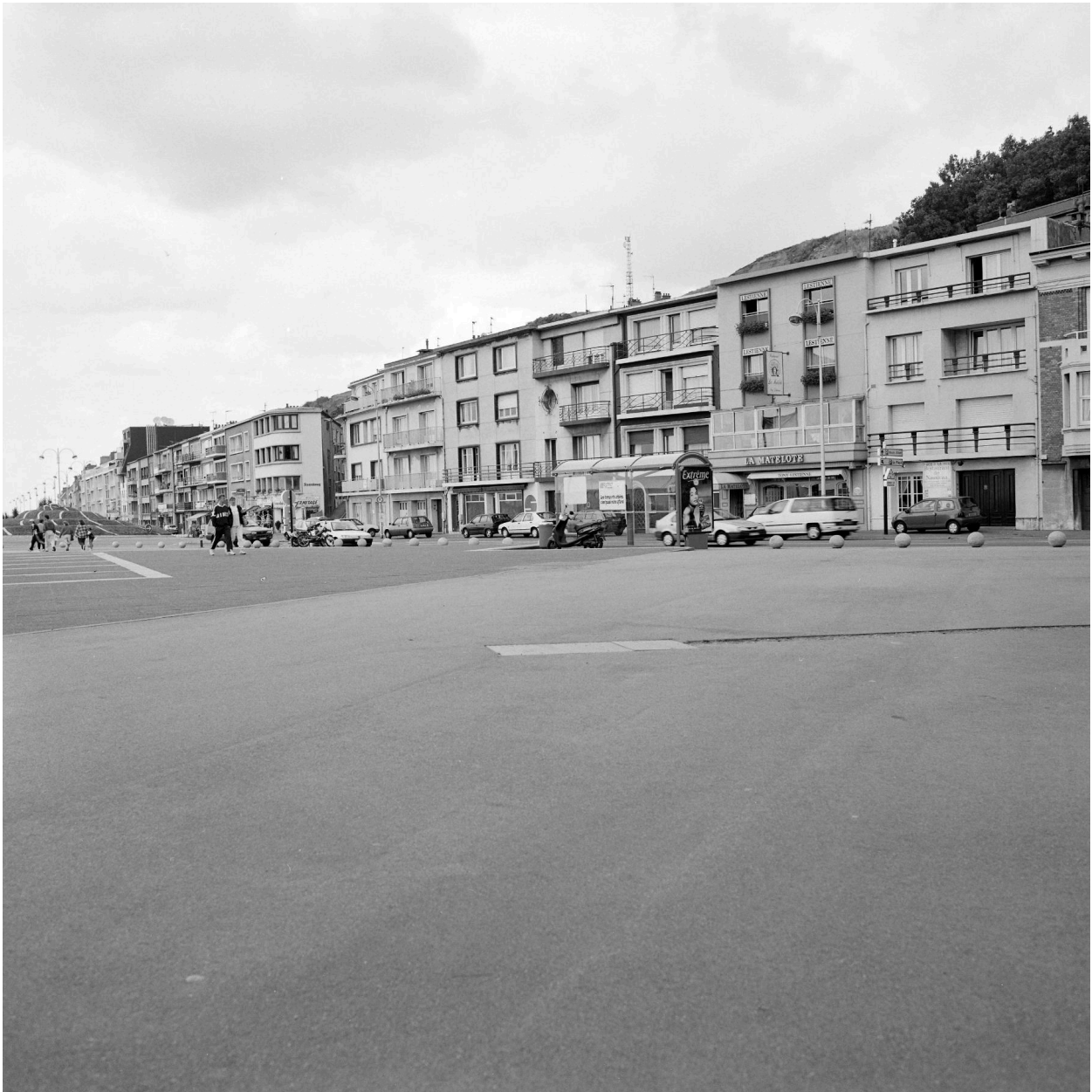
Reconstruction : boulevard Sainte-Beuve, façade sur la digue.
