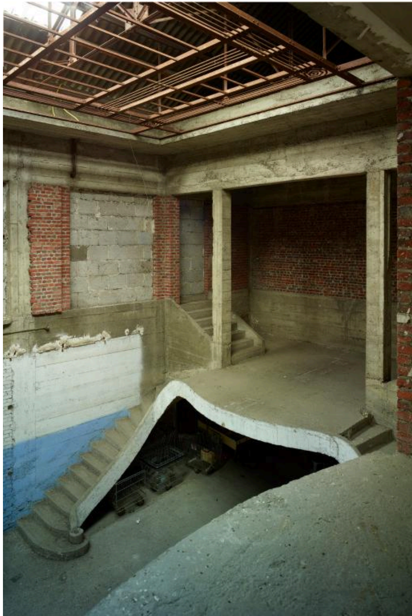
Ancienne cour à marchandises, vue de la rampe d'escalier en béton armé.
