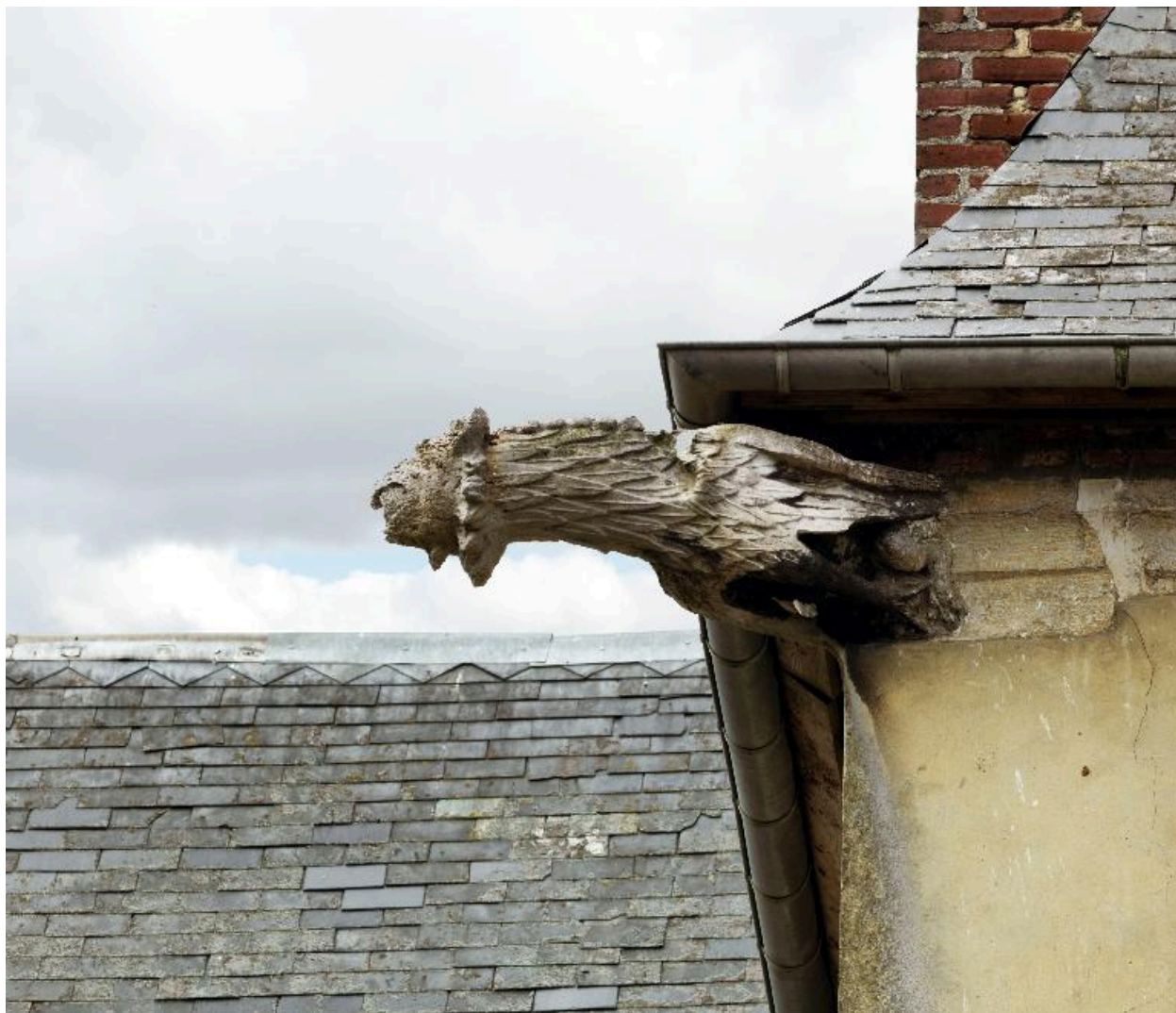
Détail d'une gargouille à gauche de la corniche.
