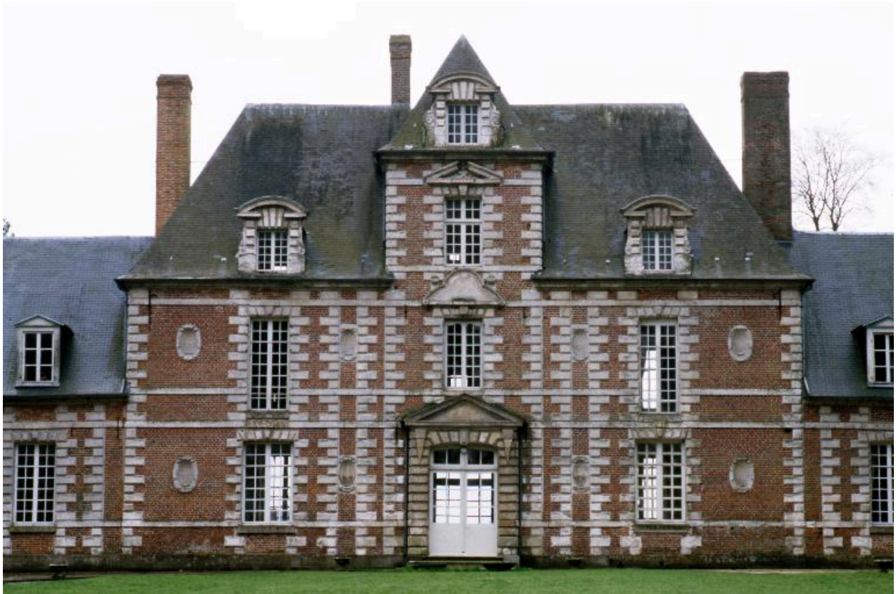
Façade du corps de logis principal sur cour (vue resserrée).
